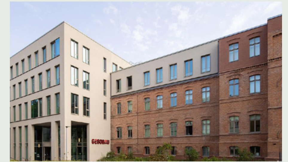
Neue GESOBAU-Zentrale in Berlin-Pankow
