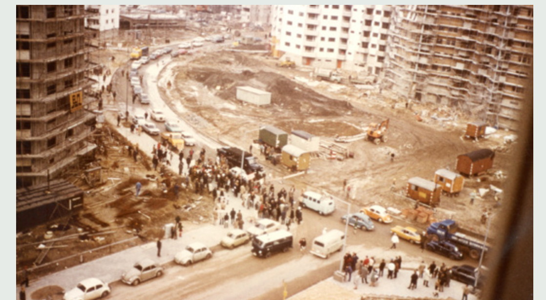
Bau der Großsiedlung Märkisches Viertel
