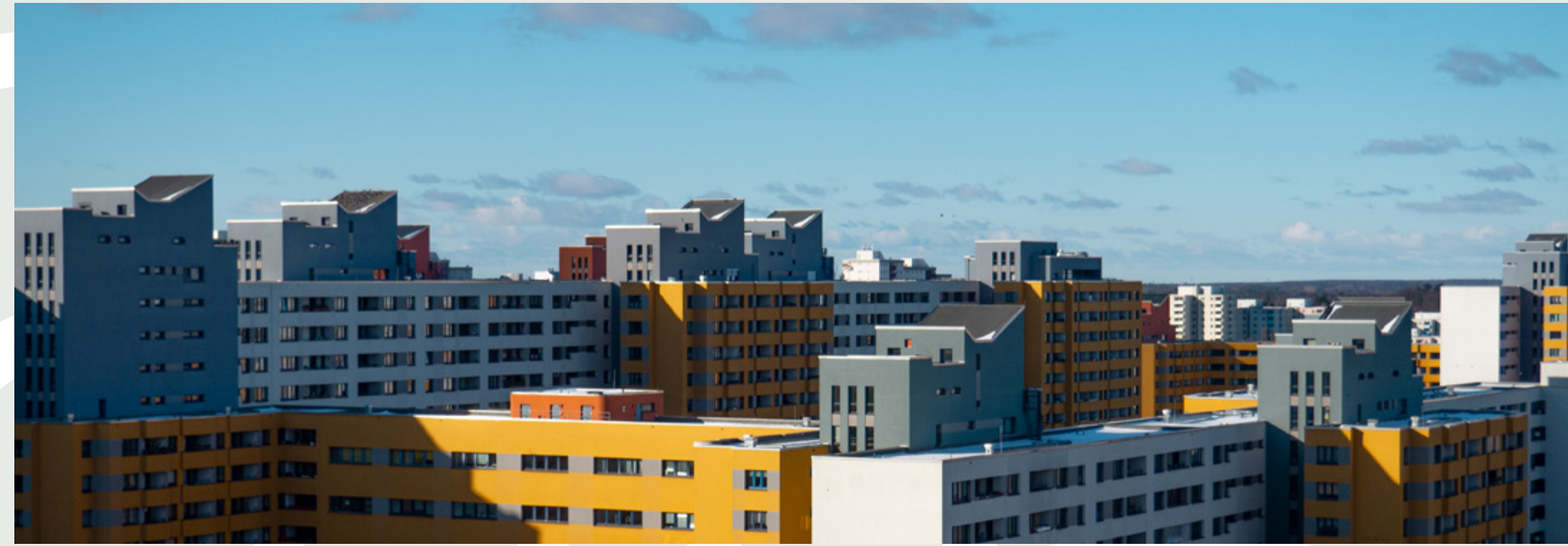
Panorama Märkisches Viertel nach der energetischen Sanierung
