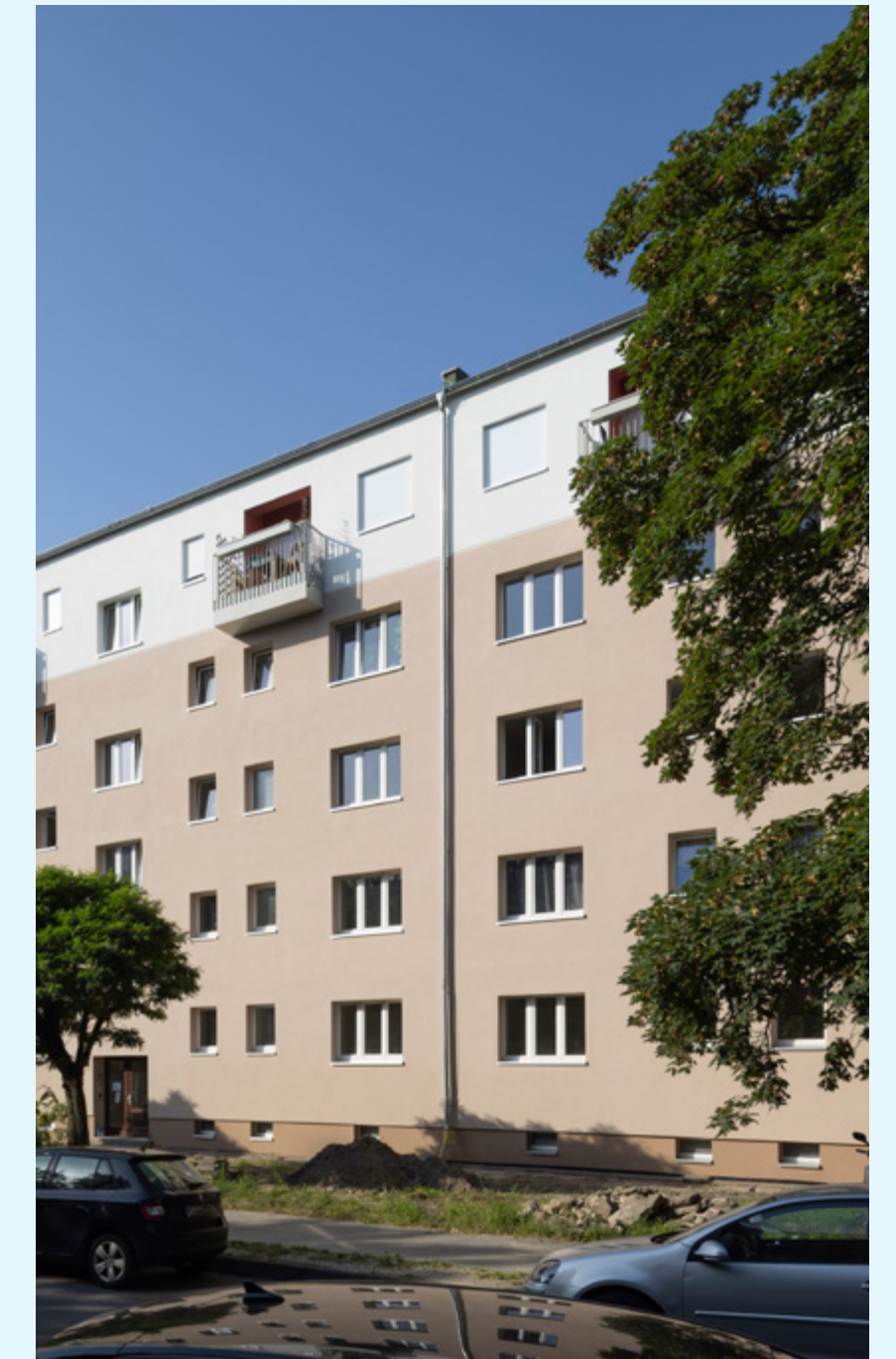
Dachaufstockung Wolfshagener Str. / Stiftsweg
