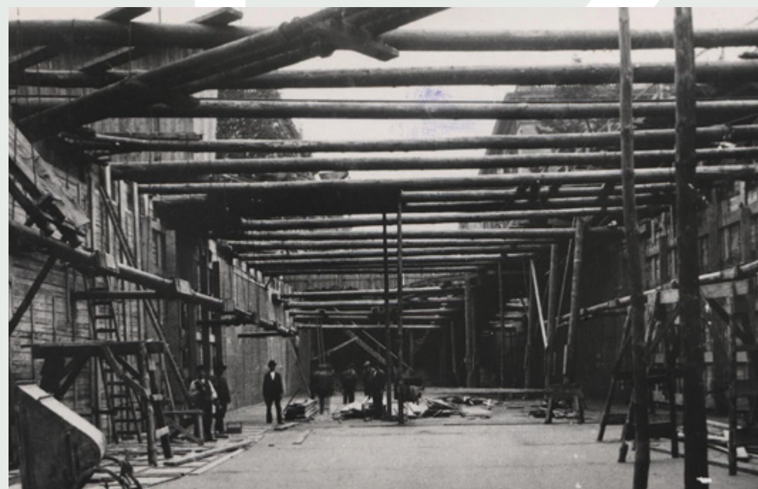
Die Schwarz-Weiß-Aufnahme aus dem BVG-Archiv zeigt einen im Bau befindlichen U-Bahn-Tunnel.
